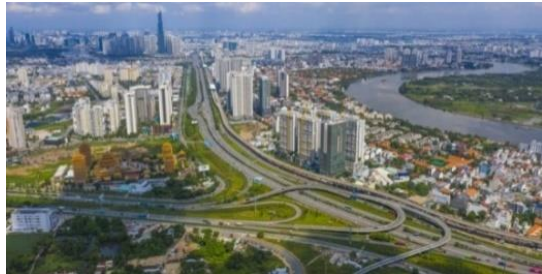
ホーチミンで建設中のメトロ1号線
