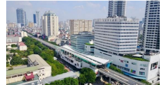
ハノイで建設中のメトロ3号線
