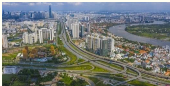
ホーチミンで建設中のメトロ1号線
