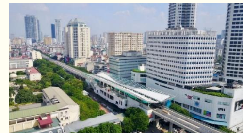
ハノイで建設中のメトロ3号線
