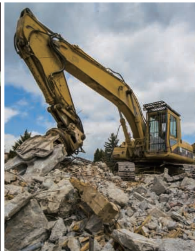
建機の遠隔操作
