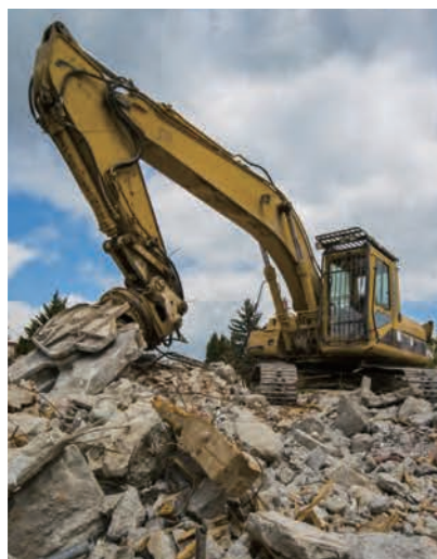
建機の遠隔操作
