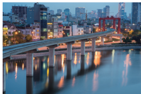
ハノイ市。 ドンダー湖と建設中の橋
