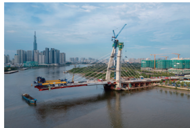
ホーチミン市。建設中の橋
