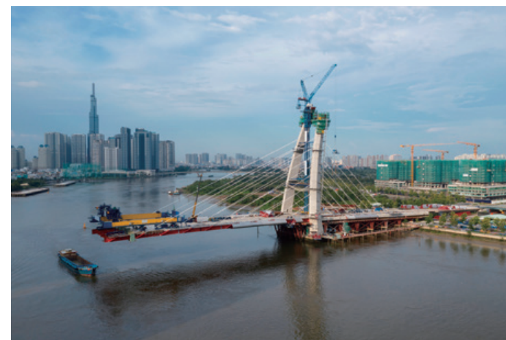
ホーチミン市。建設中の橋
