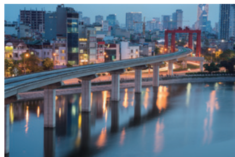
ハノイ市。 ドンダー湖と建設中の橋
